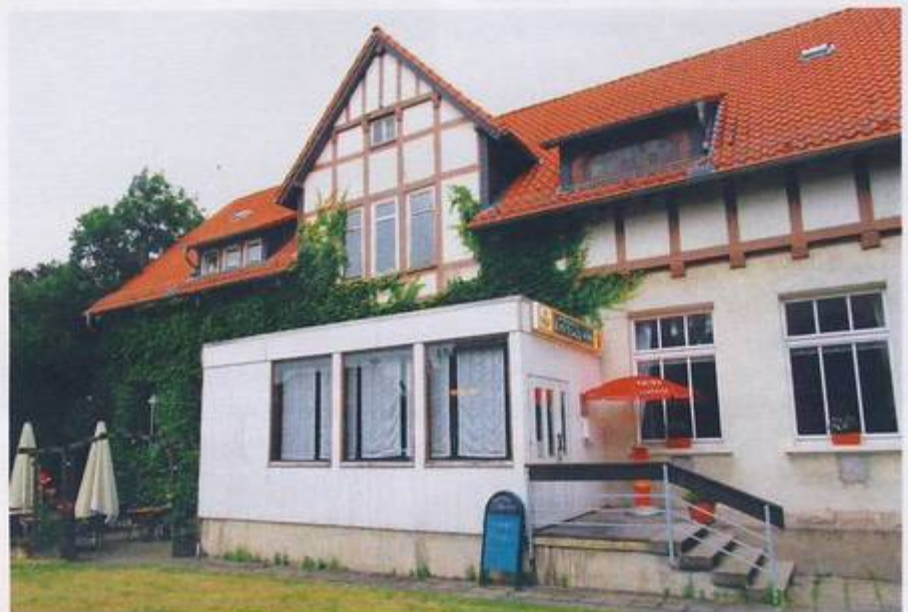
Das Kulturringhaus an der Bolkenhainstraße
