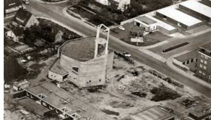
Bau der Dietrich-Bonhoeffer-Kirche, 1964.
